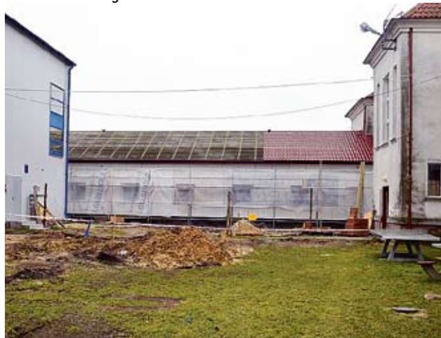
Budowa łącznika w Szkole Podstawowej w Konikowie
