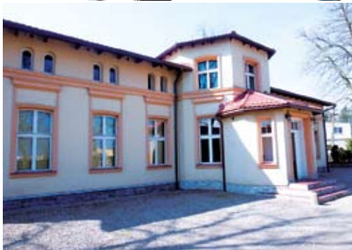
Wyremontowany dworek w Giezkowie
